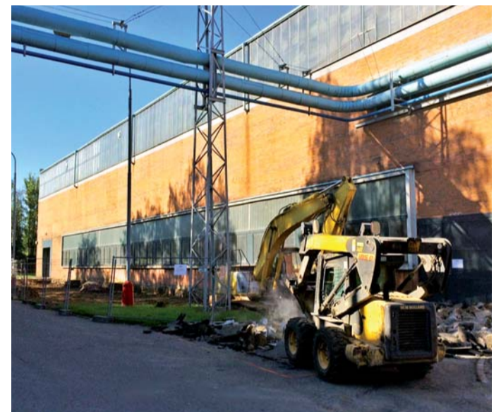
Zahájení zemních prací.
