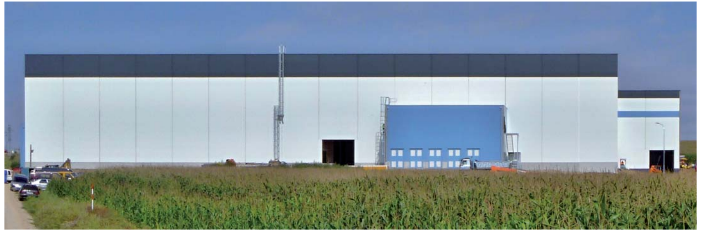
Skladovací hala č. 1 s trafostanicí, v pozadí skladovací hala č. 2 se zakládá.
