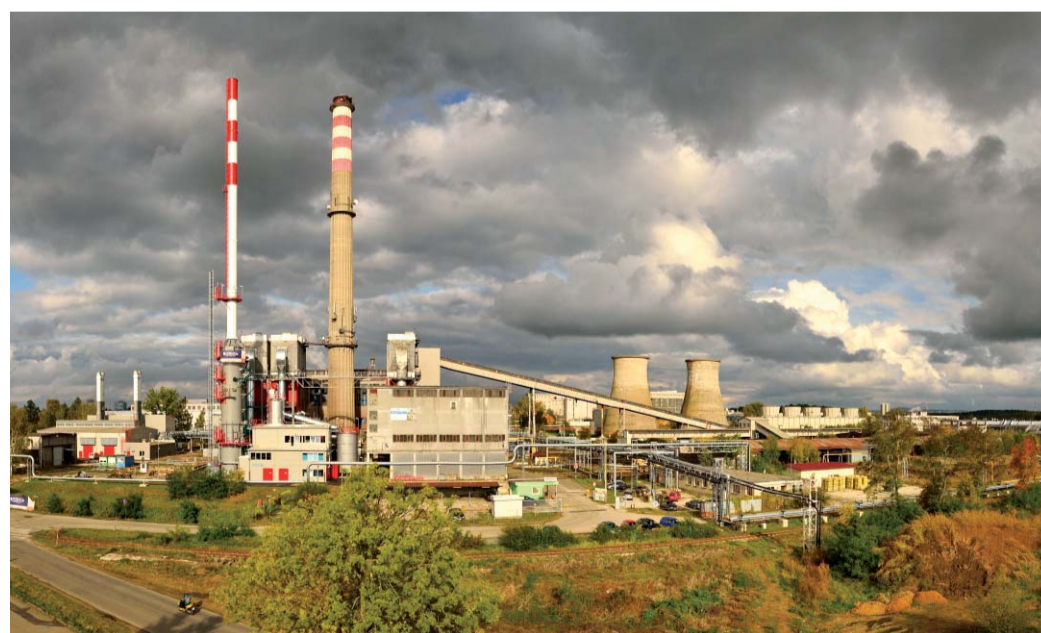
Teplárna Planá nad Lužnicí
