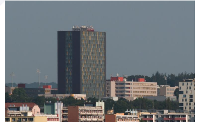
FSI VUT Brno, rekonstrukce objektů A2 a KH2
